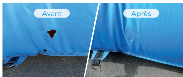
Réparation en soudure
